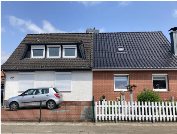
Abbildung 9: Gebäude (re.) mit niedrigem Instandsetzungsbedarf im Fritz-Reuter-Weg
