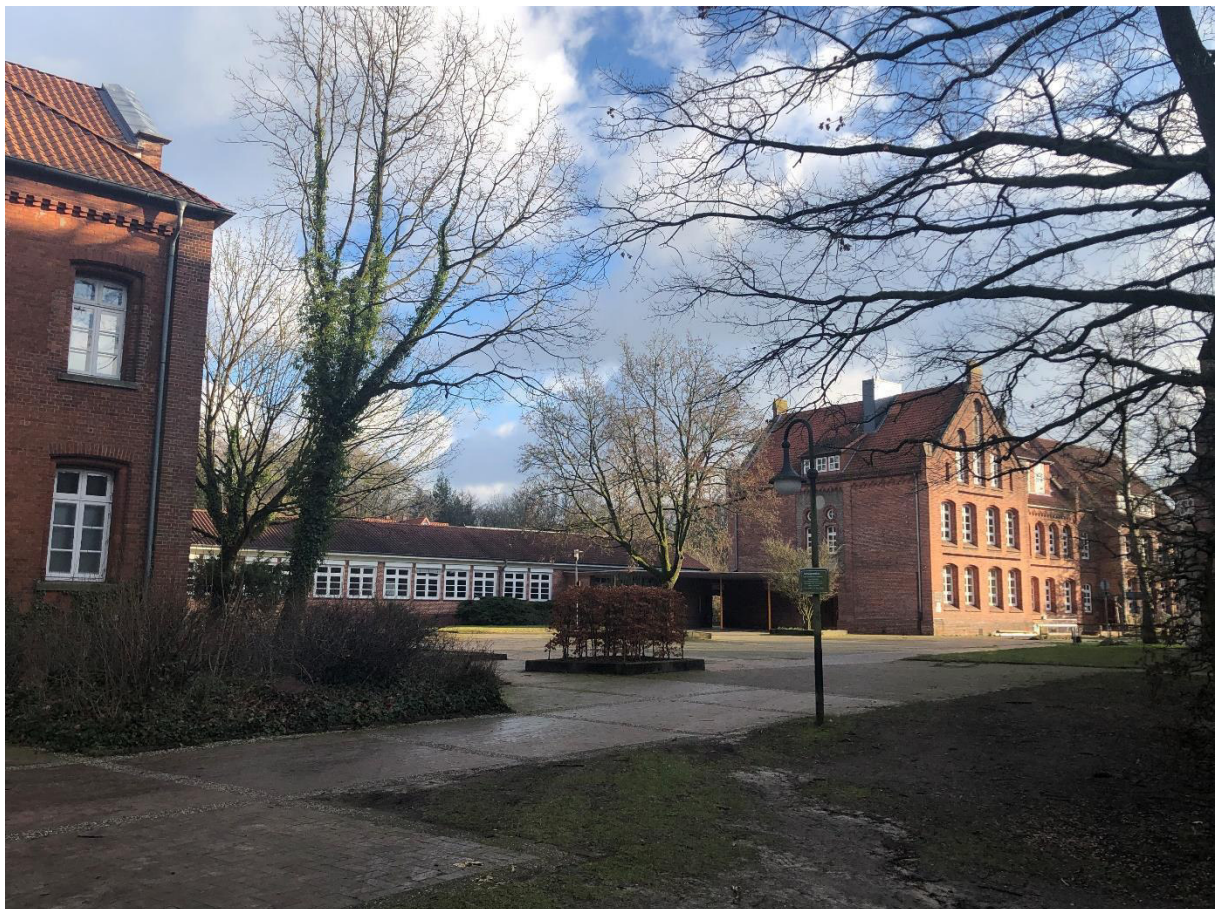
Abb. 10: Hauptgebäude und „Holländertrakt“ (Quelle: Bild, DSK)
