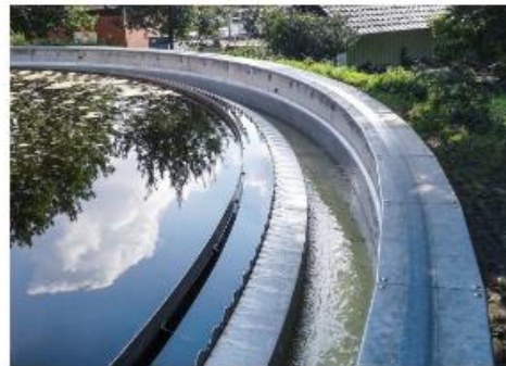
Sanierung der Ablaufrinne des Nachklärbeckens auf der KA Sassenberg
