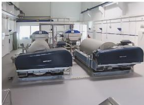
Erneuerung der Schlammbehandlung auf der KA Cuxhaven
