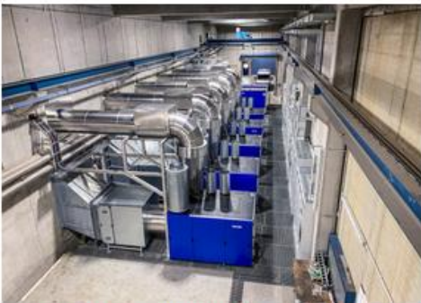
Erneuerung der Turboverdichterstation BC auf der KA Bremen-Seehausen
