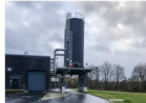
Erneuerung der Schlammentwässerung auf der HKA Münster
