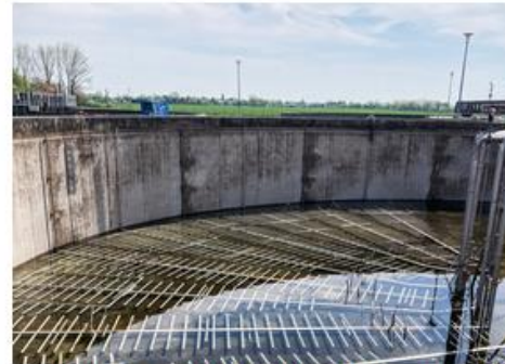
Erneuerung der Belüftungstechnik in den Belebungsbecken auf der KA Neustadt (Dosse)
