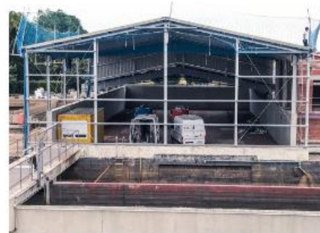
Neubau einer Schlammentwässerungsanlage auf dem Klärwerk Vechta
