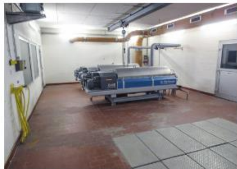
Erneuerung der maschinellen Schlammbehandlung auf der ZKA Bernburg
