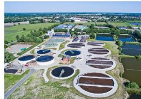
Modernisierung und Erweiterung der biologischen Reinigungsstufe auf der ARA Edewecht
