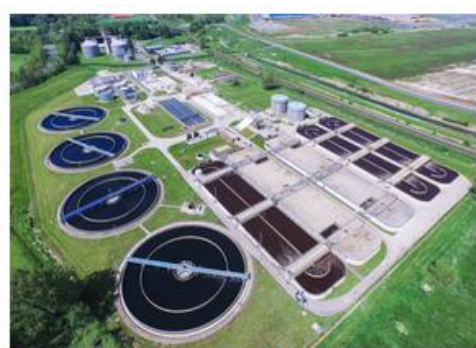
Erweiterung der biologischen Reinigungsstufe auf der KA Cuxhaven
