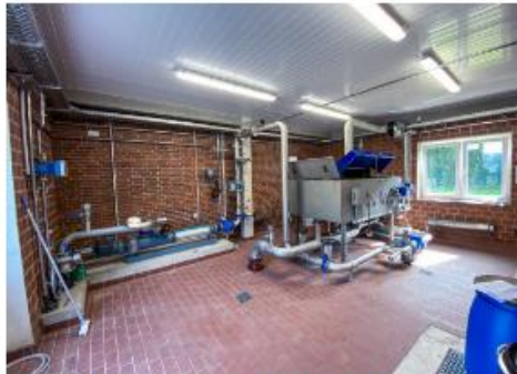
Errichtung einer Schlammeindickanlage auf der Kläranlage Ahlhorn
