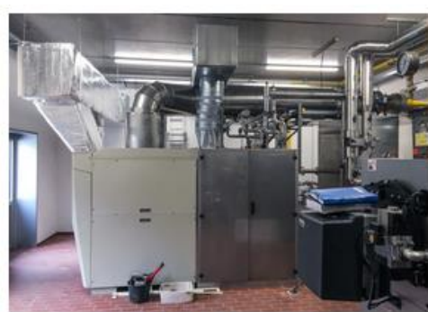
Energiehaus auf der KA Papenburg
