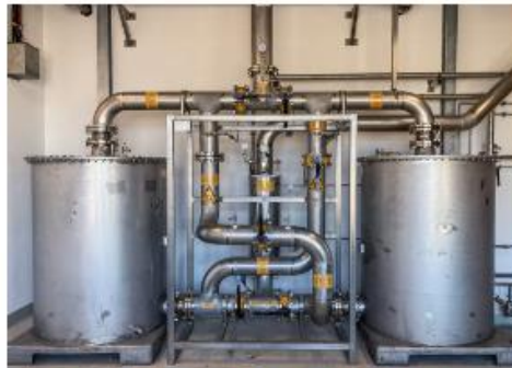
Neubau eines Gasspeichers sowie zweier BHKWs auf der KA Rheine-Nord
