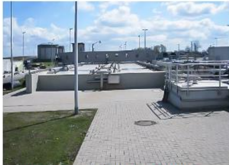
Sanierung der Sand- und Fettfänge auf der KA Cuxhaven
