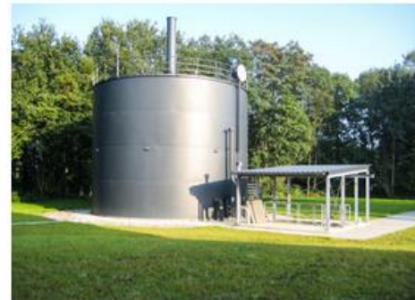
Neubau eines Gasspeichers auf der HKA Münster
